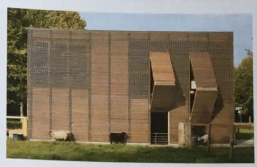
Petite boîte de mélèze posée au milieu des champs, le bâtiment est une ferme à lui tout seul.
